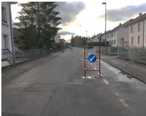
Zone 30 à Porrentruy avec aménagement n'interrompant pas la trajectoire des cyclistes
