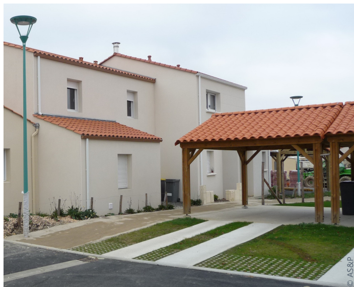
Stationnement aérien et abrité Architecture d'inspiration traditionnelle Pont-St-Martin (44) - Le Haugard 3
